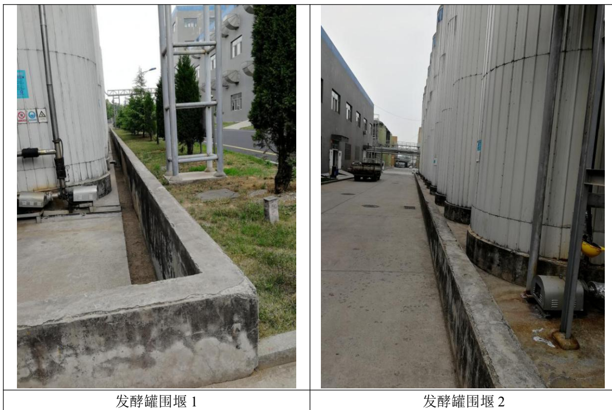
图 2.1-5 主要污染物治理设施及防护措施图
